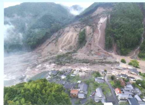
九州北部豪雨(2017年) 豪雨により大規模な土砂崩れが発生
