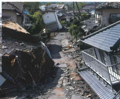
熊本地震(2016年) 震度7の強い揺れで倒壊した家屋
